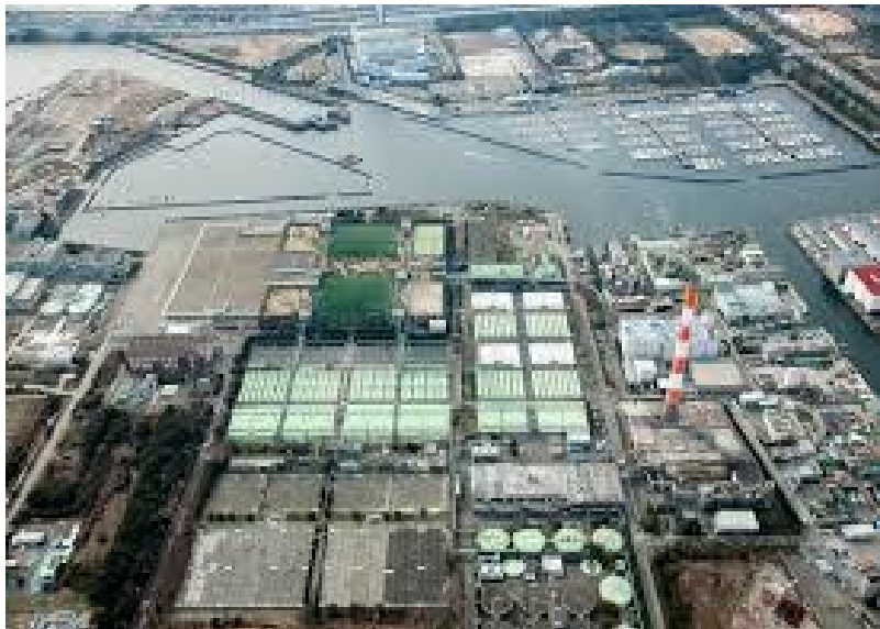
砂町水再生センター (江東区新砂町)
