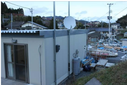
衛星受信用パラボラアンテナを設置
